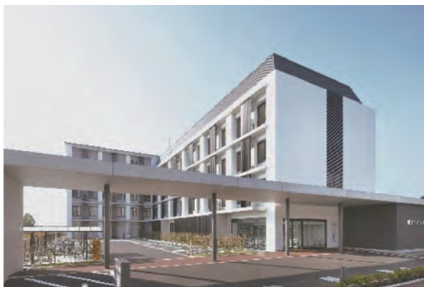
がくさい病院 京都市域京都府地域リハビリテーション支援センター 〒604-8845 京都市中京区壬生東高田町1番9
