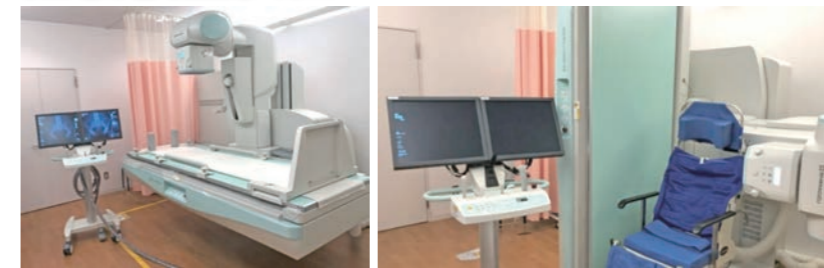
透視撮影検査室
